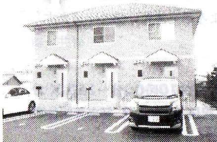
えんじゅの家（メソネット形式） 真ん中の部屋だけを借りている
