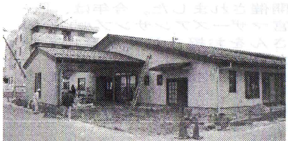
増築工事中写真
